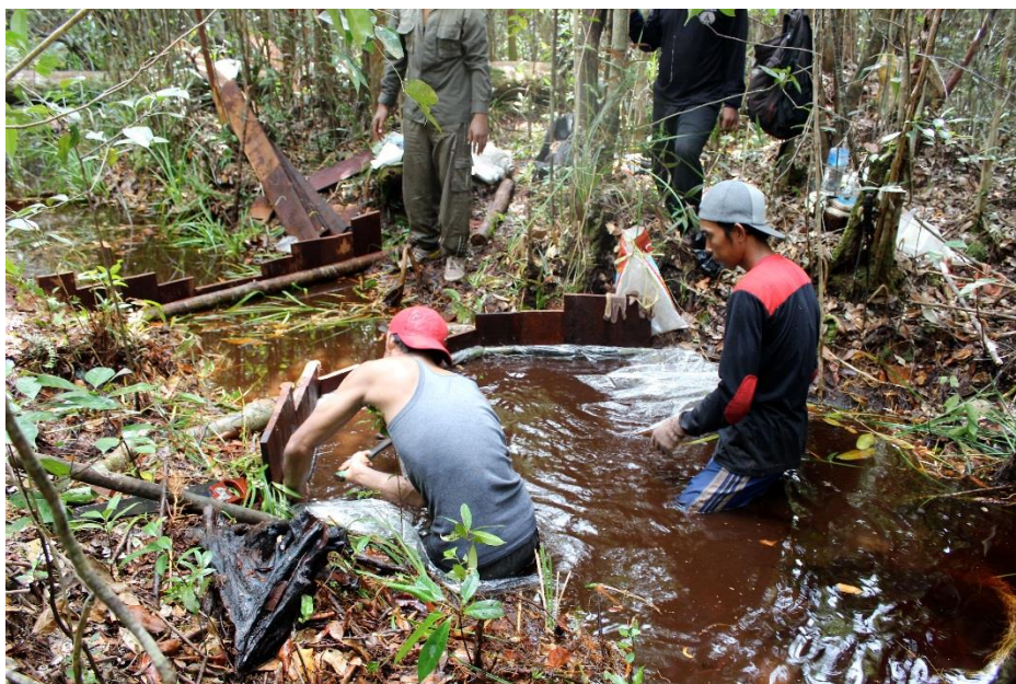
Figura 32: Construcción de una presa en un canal de drenaje en el bosque de pantano de turba de Sebangau en Indonesia. Foto: BNF.
