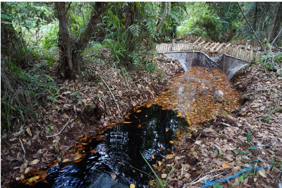
Gambar 31: Bendungan yang menghalangi kanal drainase di hutan rawa gambut tropis di Indonesia. Foto oleh Sara Thornton/CIMTROP/BNF.
