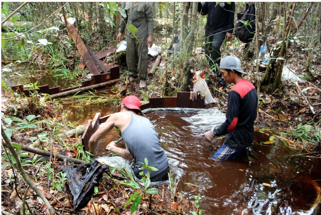
Gambar 32: Membangun bendungan di saluran drainase di hutan rawa gambut Sabangau di Indonesia. Foto oleh BNF.
